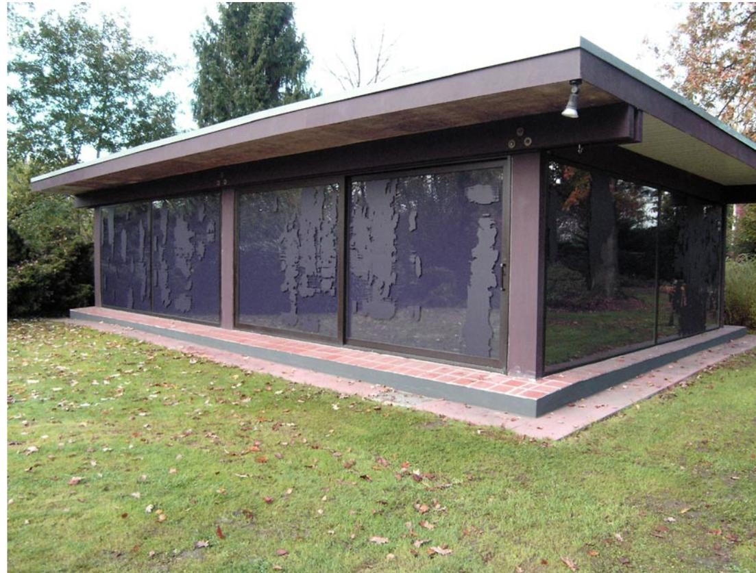
Der Pavillon hat eine Größe von ca. 8 x 6 x 2 m. Die Glasflächen wurden von innen mit einem violetten Farbton (Acryl/Dispersion) geschlossen. Von außen wurde der gleiche Farbton (LUKASCRYL-pastos Permanentviolett) aufgetragen.
